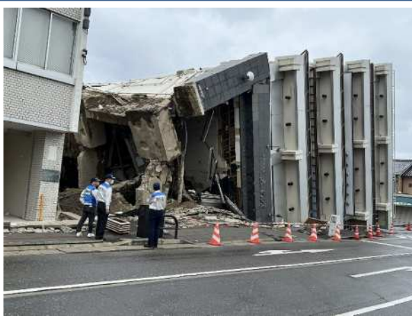
▼ 5.8 被災地視察（輪島市）にて 全壊した建物がある一方で、無傷の建物も多い状況。被害の大小の原因究明が必要と認識
