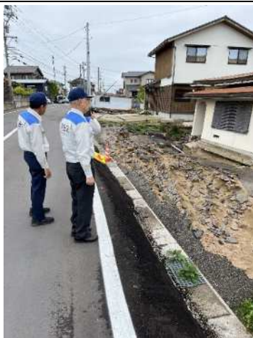
▼ 5.8 被災地視察（内灘町） 液状化により吹き出す砂や地盤沈下、傾いた建物が多く見られる状況
